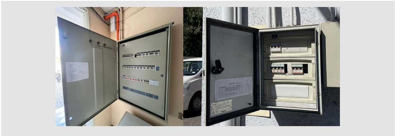
Figura 28: Nuevos tableros eléctricos.
