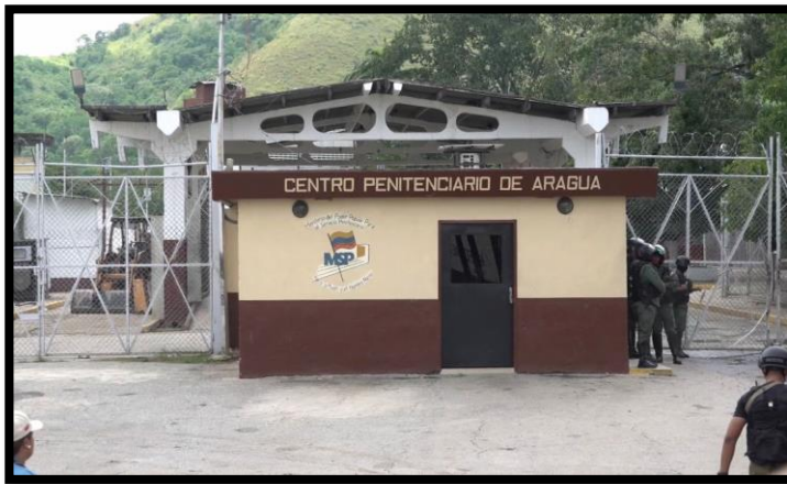
Figura N°1: Centro Penitenciario de Aragua.
